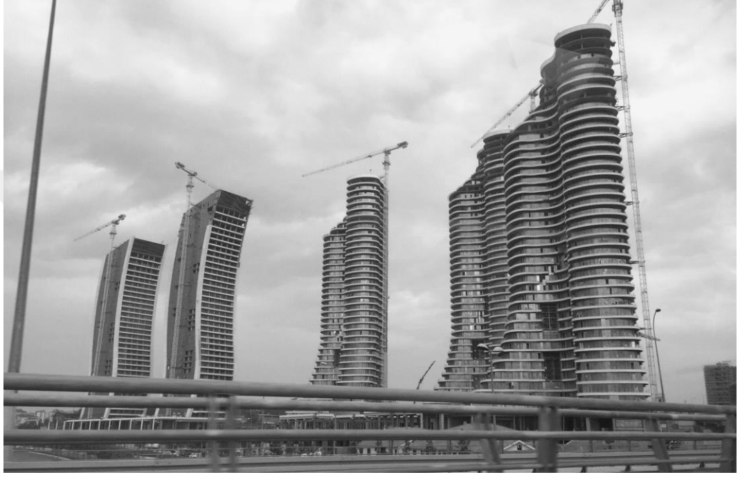
Şekil 2.8 : İstMarina Projesi inşaatı.
