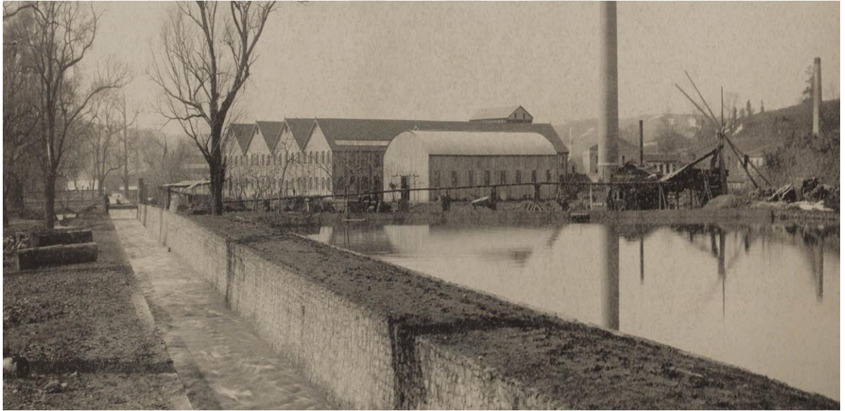
Görsel 3: Beykoz Sümerbank Deri ve Kundura Fabrikası
