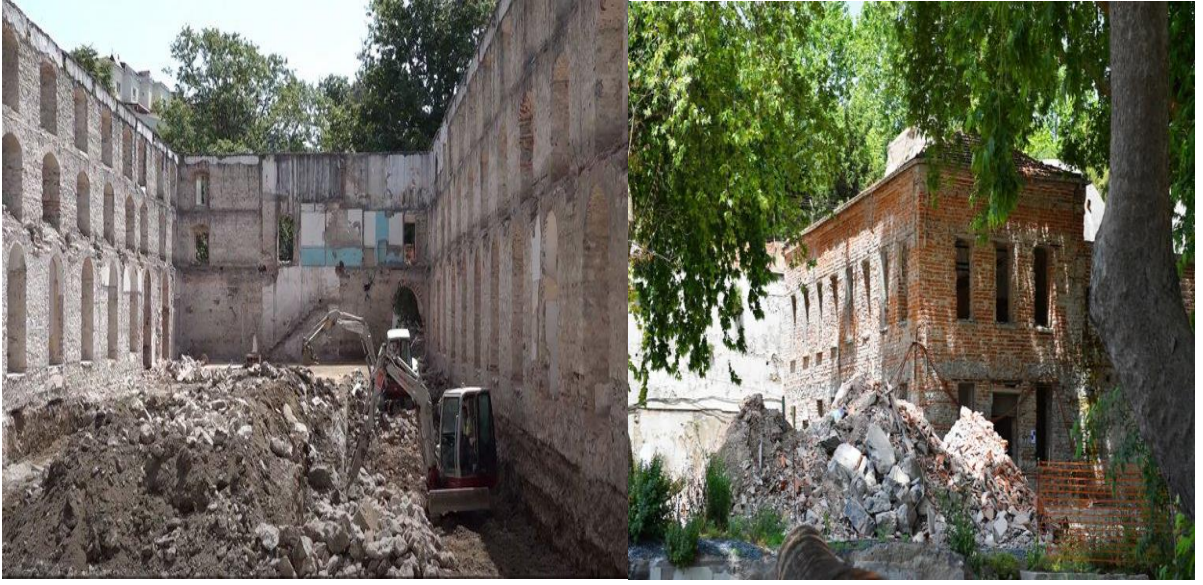
Görsel 40: Tersane İstanbul Çalışmasında Yıkım
