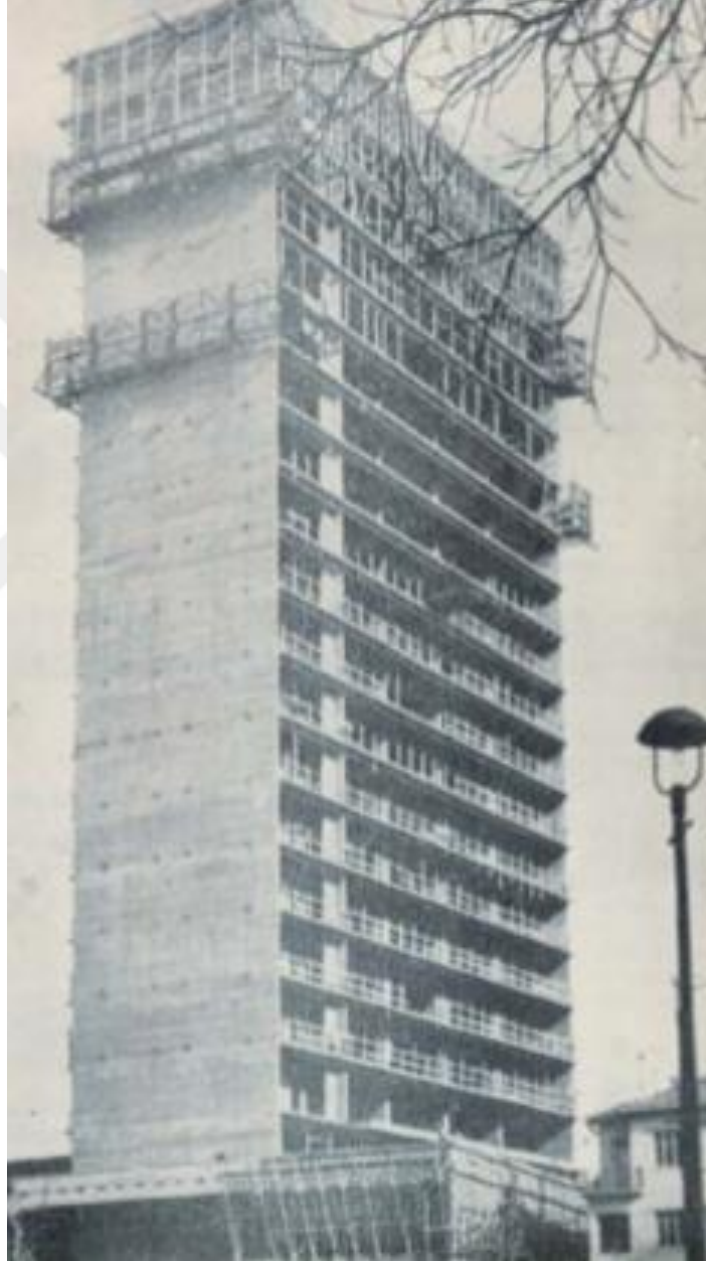
Şekil A.53 Kızılay Emek İşhanı inşaat aşaması (Türkiye Mühendislik Haberleri, 2006)
