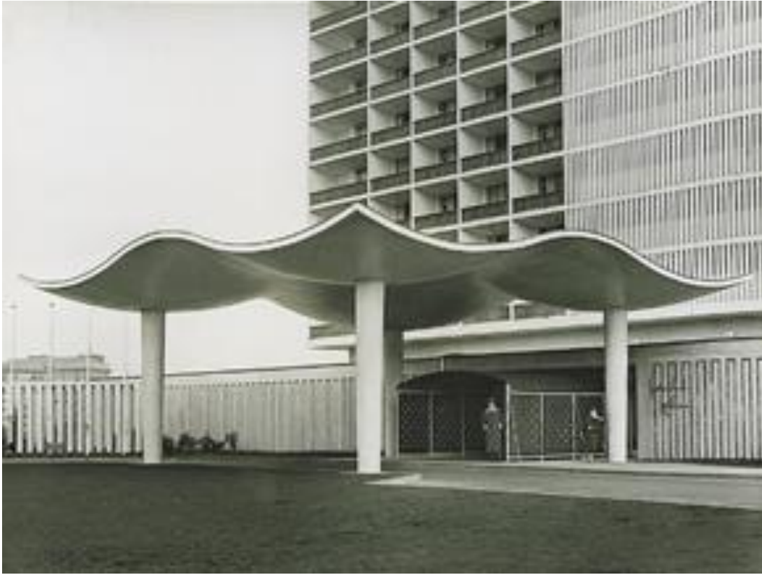
Şekil A.45 Hilton Oteli, uçan halı formunda saçak silmesi detayı ( https://www.archives.saltresearch.org )
