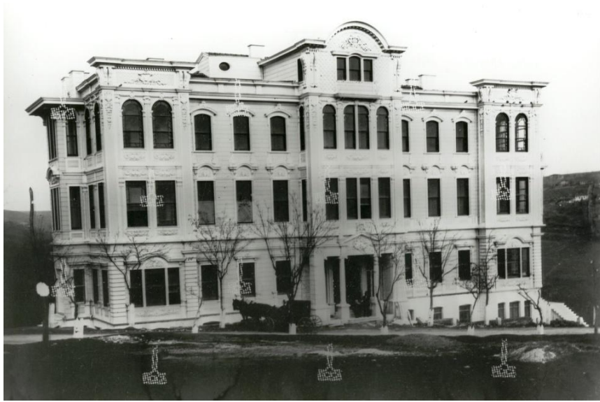
Şekil 4.4 : Ihlamur'da Fehim Paşa Konağı'nın inşaatı henüz bitmiş olduğu zamanki görünümü. (Foto Miralay Ali Sami, IRCICA Fotograf Arşivi no: 90647/28)
