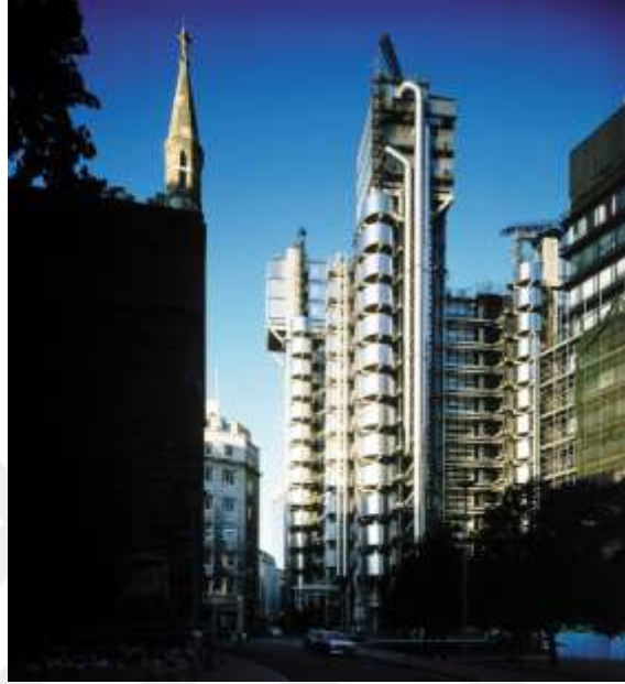
Şekil 4.7 : Rogers’ın Lloyd’s of London Binası (Url-30).
