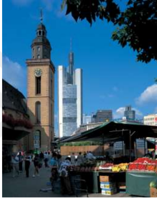
Şekil 2.10 : Commerzbank Binası (Url-6).
